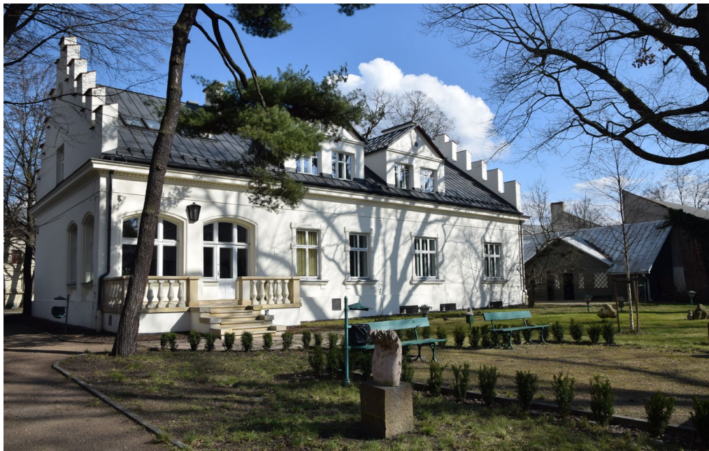
Biblioteka Główna po remoncie, 2020 r., fot. z archiwum Biblioteki Kraków
