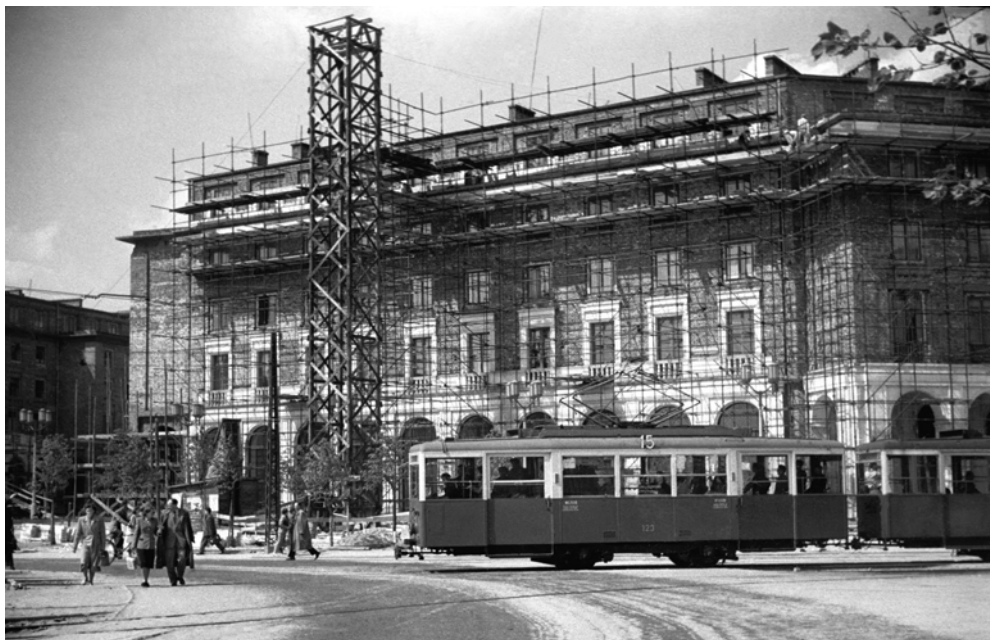
Nowa Huta w budowie
