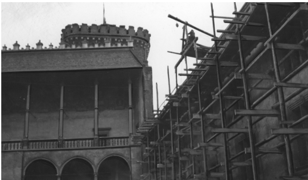
Przebudowa zachodniego skrzydła zamku na Wawelu na Kancelarię Generalnego Gubernatora, źródło: nac.gov.pl , sygn. 2-2785
