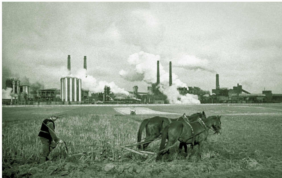
Nowa Huta w budowie
