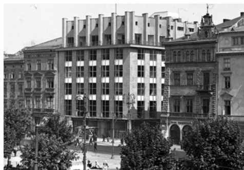
Dom „Feniksa” przy Rynku Głównym 41 projektu Adolfa Szyszko-Bohusza, stan sprzed 1939 r., fot. Bronisław Pindelski, „Ilustrowany Kurier Codzienny”
